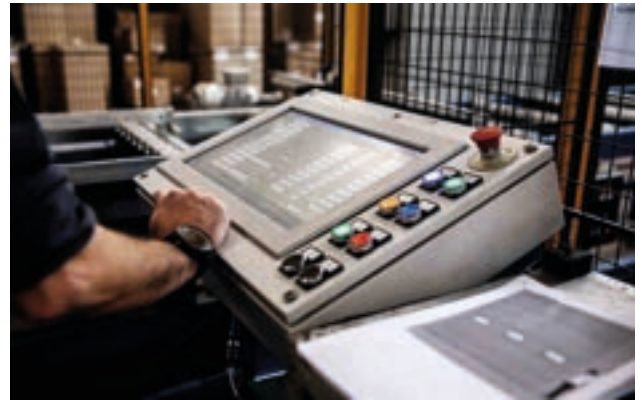
Sistema di controllo automatizzato. Automated control system.
